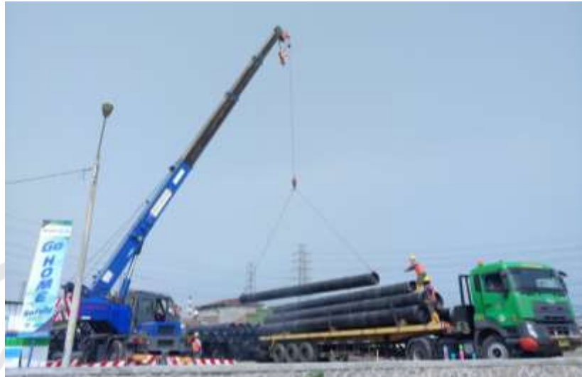
Gambar 5.6 Mobilisasi material pipa 24”
