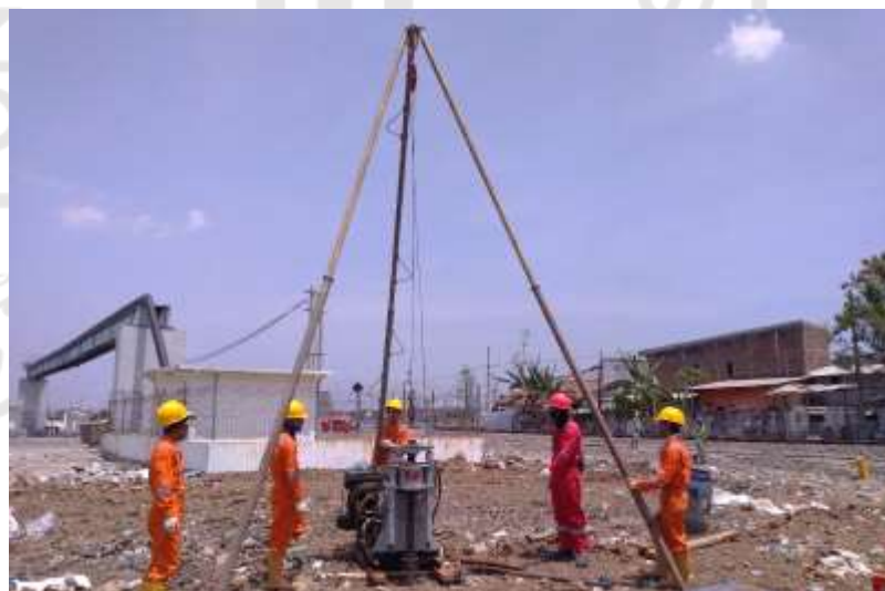
Gambar 5.8 Pengujian sondir dan boring di sisi rel kereta api
