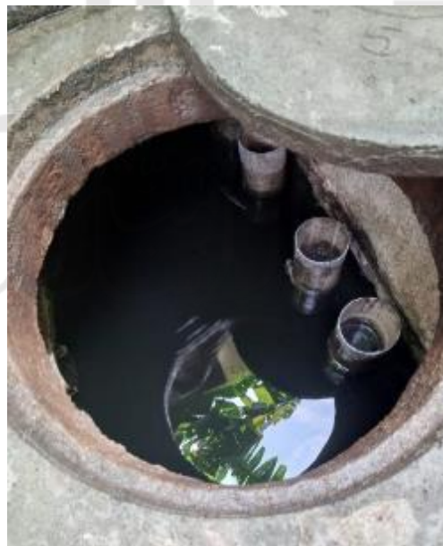
Gambar 4. 9 Kondisi Tangki Outlet IPAL Gading Indah (sumber : dokumentasi pribadi)
