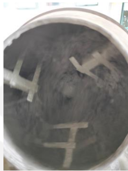
Gambar L-2.6 Proses Pembuatan Campuran Beton
