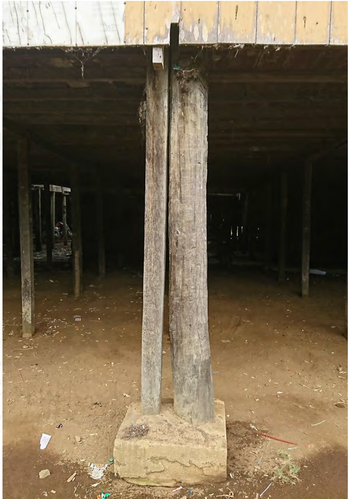
Gambar 2.2.21: Ketinggian panggung dan kolom yang berusia sekitar 160 tahun (kanan) pada Rumah Betang desa desa Konut. Sumber : Jan Gehl
