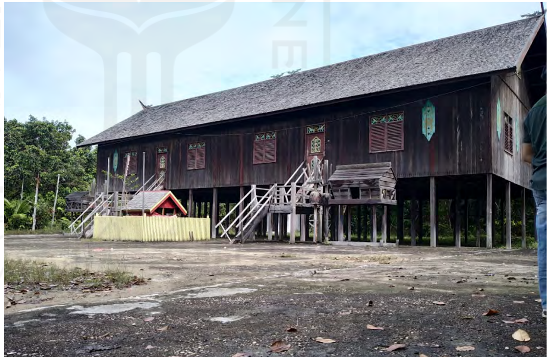
Gambar 2.2.23 : Rumah betang yang hampir keseluruhan komponennya terbuat dari kayu ulin Sumber : Penulis
