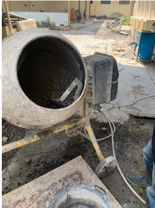
Gambar L-3.4 Proses Pembuatan Campuran CTB
