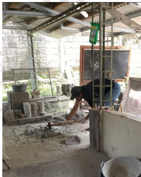
Gambar L-3.1 Proses Pemecahan Limbah Beton
