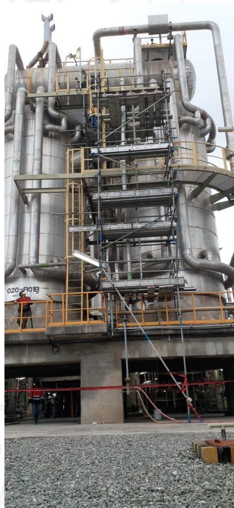
Gambar 4.4. 1 Pengerjaan Pemasangan Material Scaffolding
