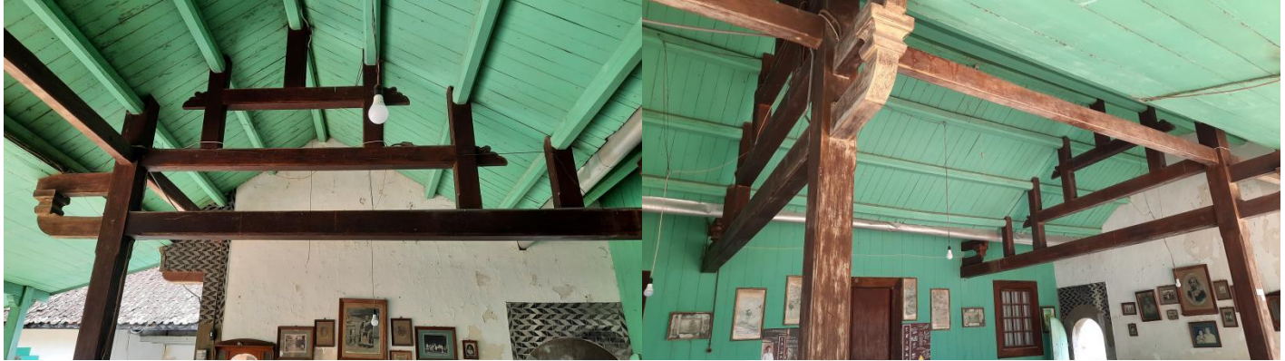
Gambar 2.14. Bentukan struktur bangunan tionghoa Lasem
