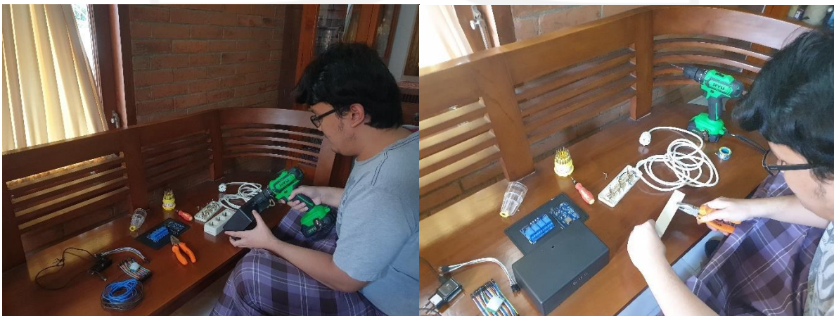
a. Gambar kanan proses pembolongan pada stop kontak dan gambar kiri proses pembolongan box
