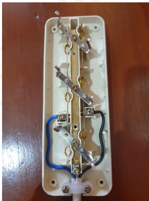
Gambar 3.8 Rancangan awal rangkaian kabel jack stop kontak
