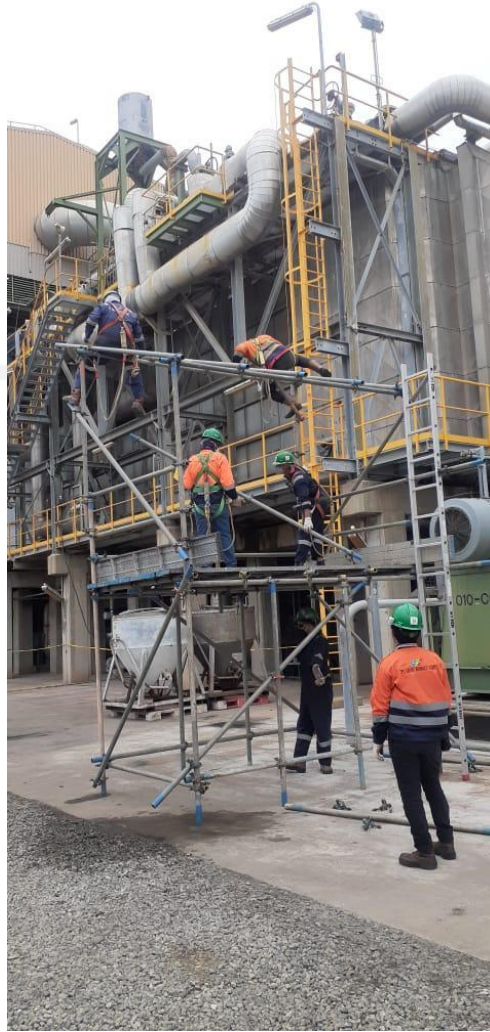
Gambar 4.4. 2 Dokumentasi Pengerjaan Scaffolding
