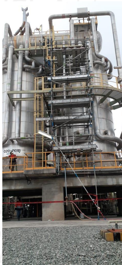
Gambar 4.4. 1 Pengerjaan Pemasangan Material Scaffolding
