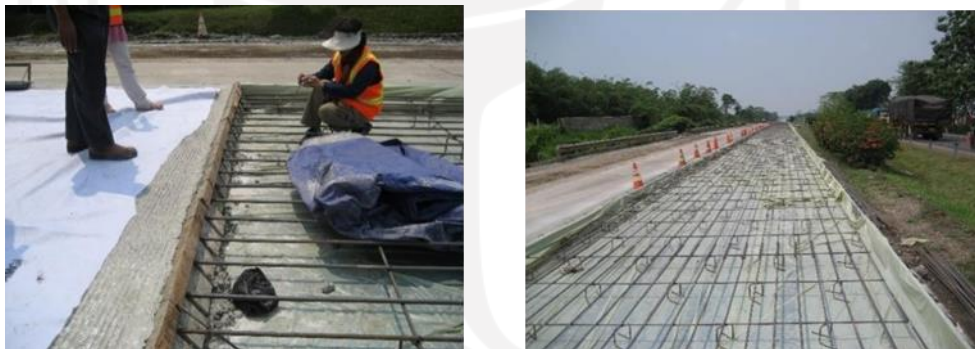
Gambar 3.6 Sambungan pelaksanaan melintang dan tulangan pada perkerasan menerus dengan tulangan (Sumber: Diklat Perkerasan kaku KemenPUPR, 2017)
