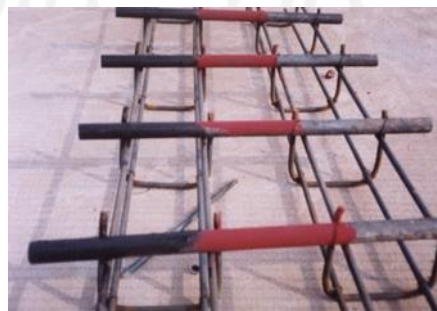
Gambar 3.3 Ruji Pada perkerasan kaku bersambung tanpa tulangan (Sumber: Diklat Perkerasan kaku KemenPUPR, 2017)
