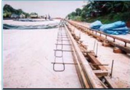
Gambar 3.4 Batang pengikat Pada perkerasan kaku bersambung tanpa tulangan
