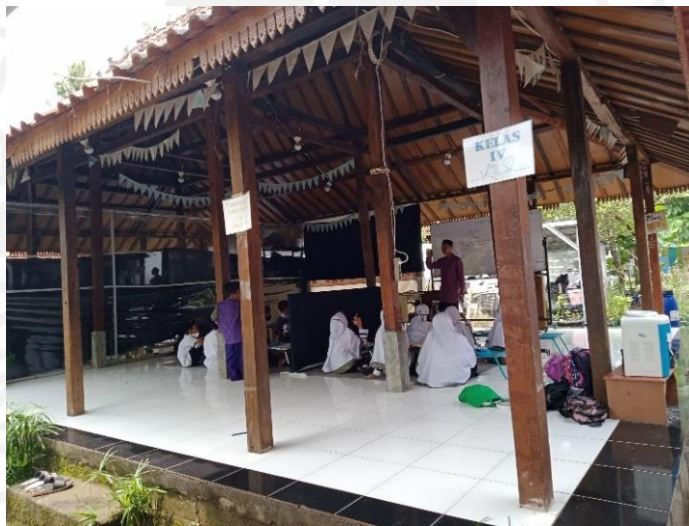
Gambar 4.2 Ruang Kelas di STP Khoiru Ummah
