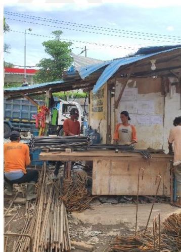
Gambar 5.2 Contoh foto pekerjaan fabrikasi tulangan kolom di proyek
