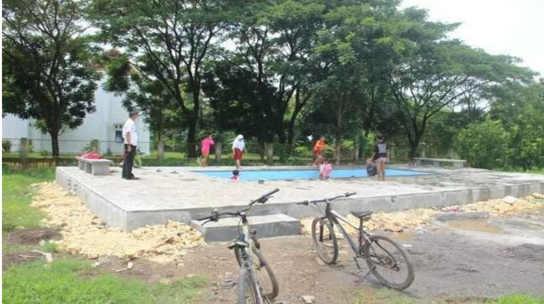
Gambar 3. 10 Pembangunan Kolam renang di Taman Kemuning , Desa Terban
