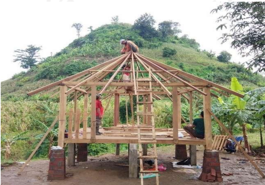
Gambar 3. 15 Pembangunan surau di sekitar komplek gua jepang, Desa Terban
