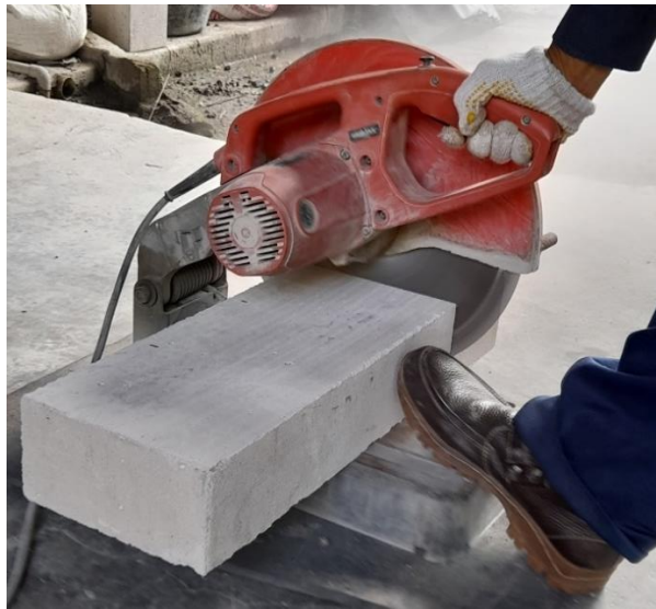
Gambar L-4.2 Pemotongan Bata Ringan Focon
