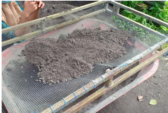
Gambar 4.4 Abu Batu yang Disaring dengan Ayakan
