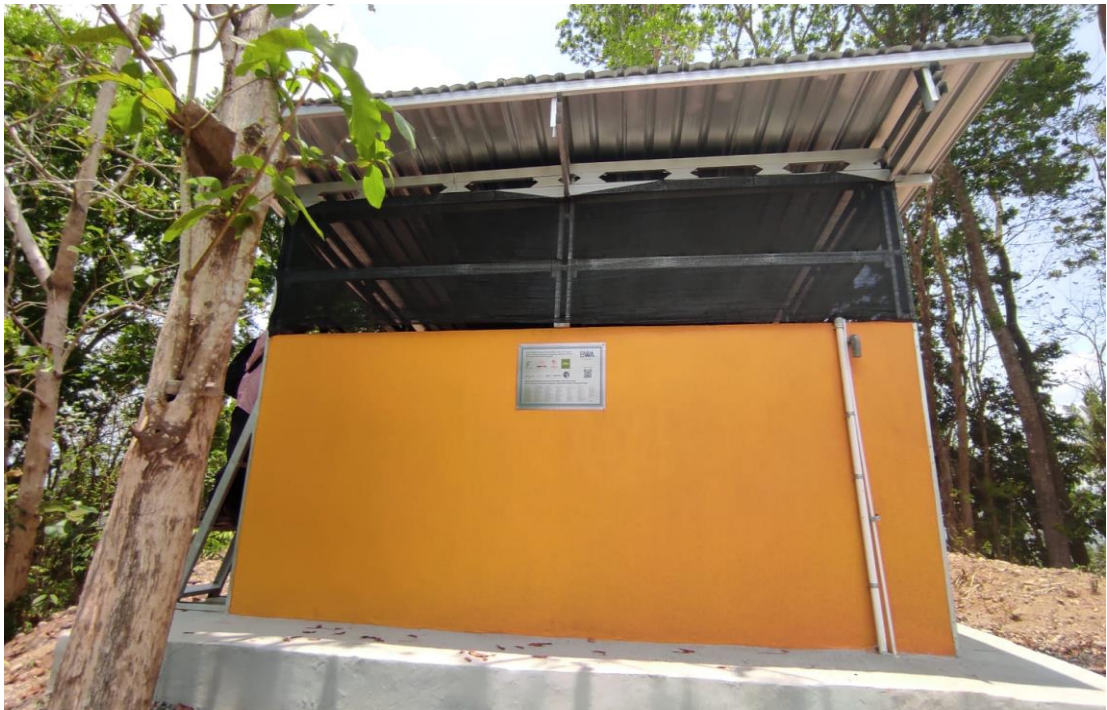
Bak penampungan air pada program action for people yang digunakan untuk menampung air tanah, Senin tanggal 11 Oktober 2021
