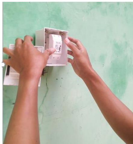
Gambar 4. 38 Percobaan pemasangan alat pada box MCB
