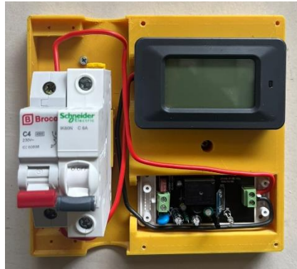
Gambar 4. 19 Pemasangan MCB Merk Broco dan Schneider
