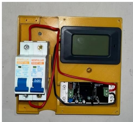
Gambar 4. 20 Pemasangan MCB Merk New Pallas
