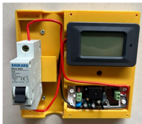
Gambar 4. 21 Pemasangan MCB Merk Shukaku
