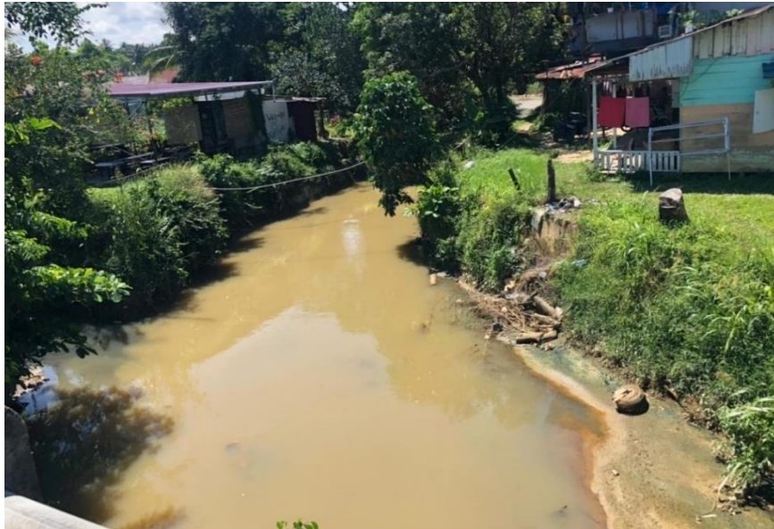
Gambar 4. 3 Penyempitan Dimensi Drainase Akibat Sedimen
