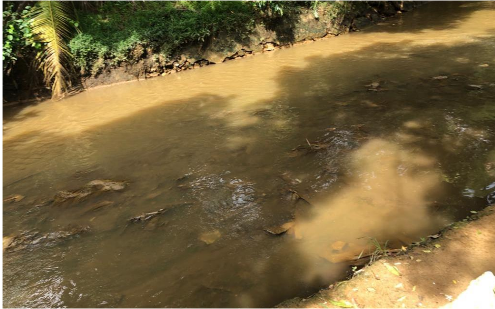
Gambar 5. 7 Penumpukan Sedimen dan Sampah di Dasar Saluran
