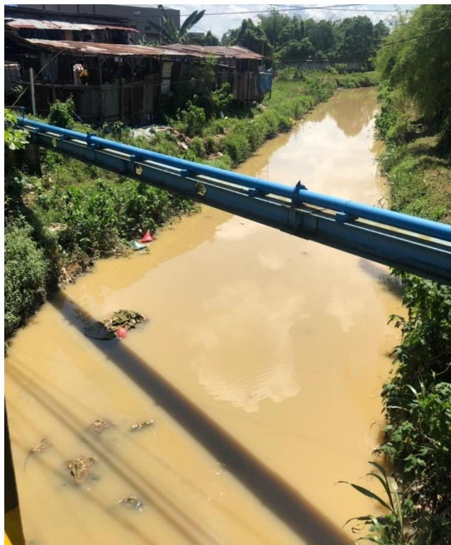
Gambar 4. 1 Penumpukan Sampah pada Drainase
