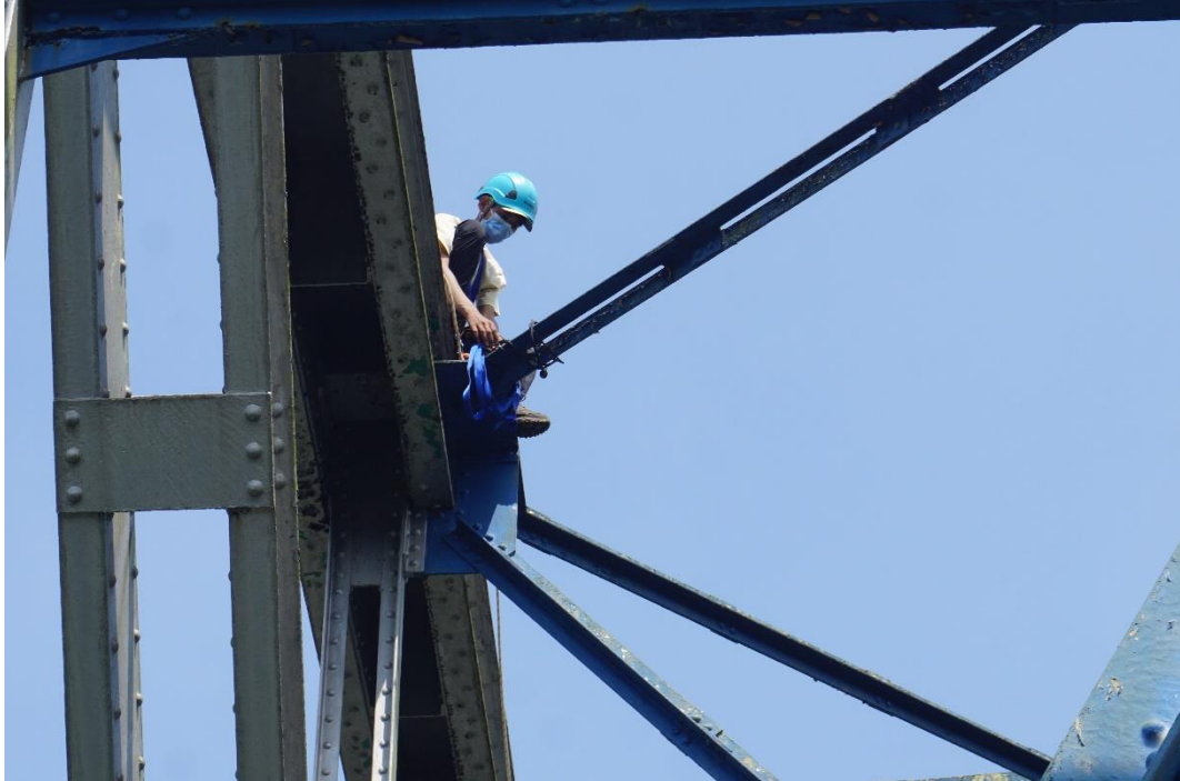
Lampiran B. 7 Pengukuran Elemen Bagian Atas Jembatan Kereta Api Mbeling I BH.2034
