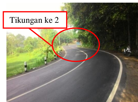
Gambar 1.2 Kondisi Geometri Jalan Dari Arah Yogyakarta
