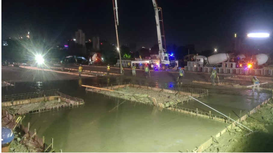
Gambar L-1.3 Pekerjaan Pengecoran Lantai Beton Untuk Dudukan Modular
