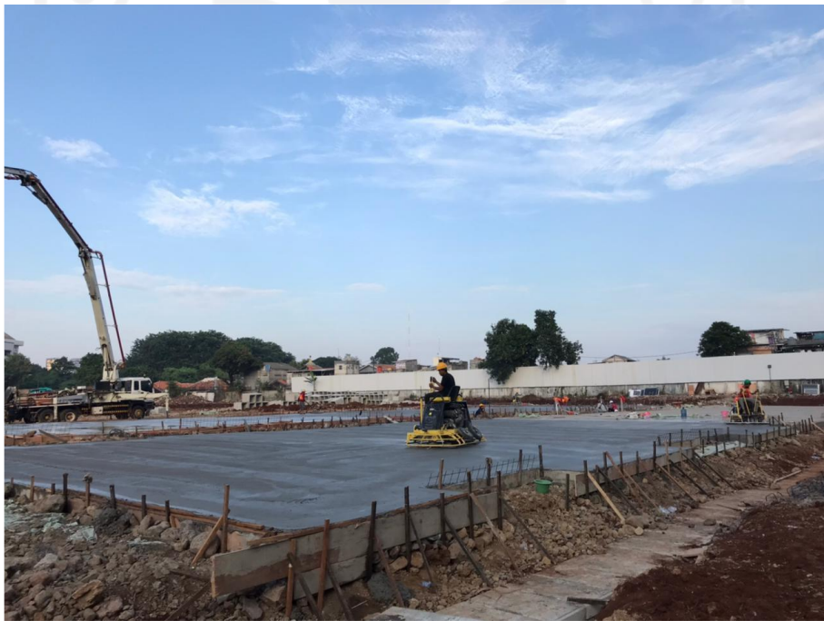
Gambar L-1.4 Pekerjaan Pengecoran Lantai Beton Untuk Dudukan Modular
