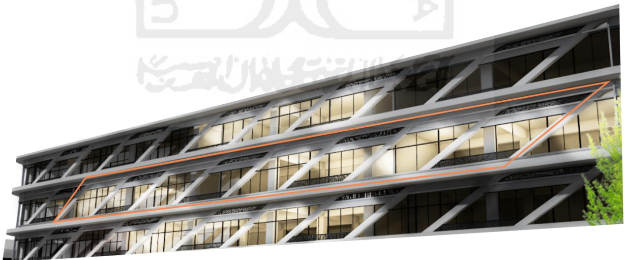
Gambar 4. 12 Bukaan Ventilasi pada Secondary Skin (Sumber : Penulis, 2016)
