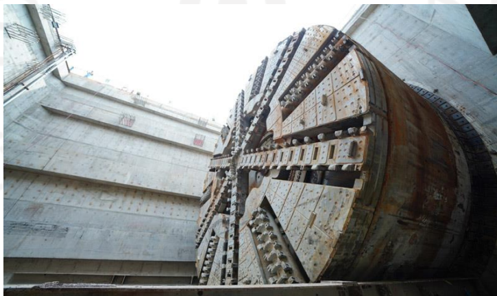
Gambar 5.1 Penggunaan Mata Bor Tunnel Bored Machine
