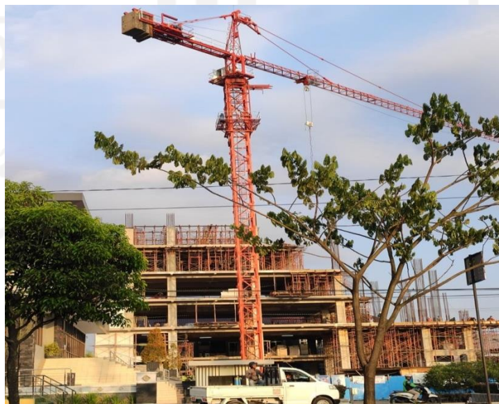
Gambar 4.2 Lokasi Pekerjaan Proyek Pengembangan Gedung Universitas Alma Ata
