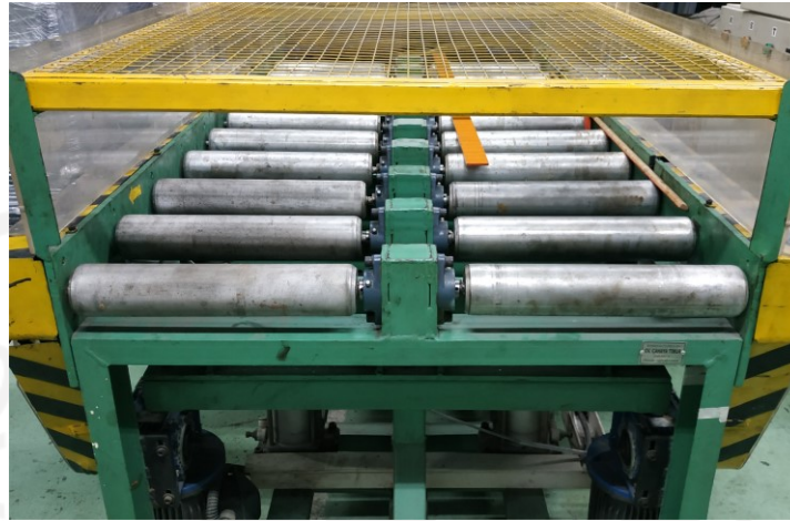
Gambar 4 - 8 Roller setelah pembongkaran
