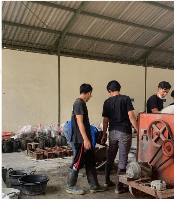
Gambar L-3.4 Persiapan proses Pembuatan Campuran beton
