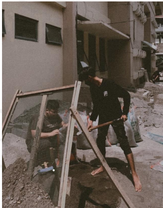
Gambar L-3.1 Penyaringan Agregat Halus
