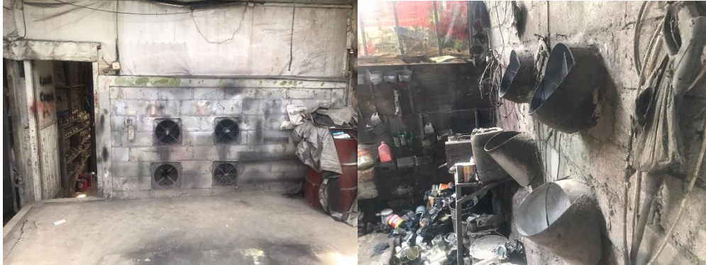
Gambar 4. 18 Kondisi Eksisting Exhausted Fan di Bengkel X
