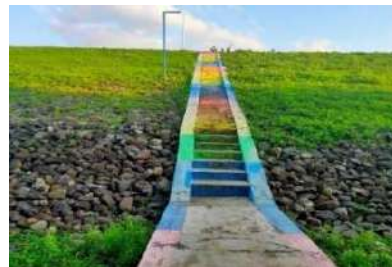
Tangga OP Bendungan
