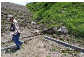
Tangga OP Bendungan
