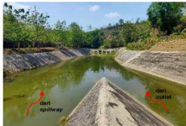
Kondisi Hilir Bendungan
