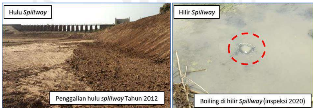
Gambar 5.1 Penggalian Waduk dan Boiling di Hilir Spillway Bendungan Dawuhan (PT. Hilmy Anugra JO PT. Ika Adya Perkasa, 2020)
