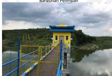
Jembatan Menara Intake
