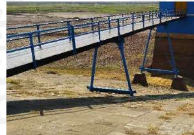
Jembatan Menara Intake
