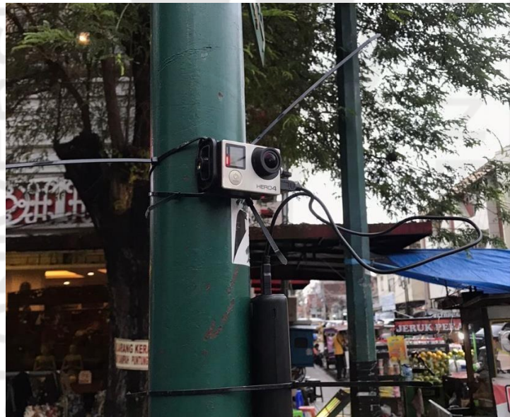
Gambar L-15.4 Kamera CCTV pada Simpang Empat Suryatmajan
