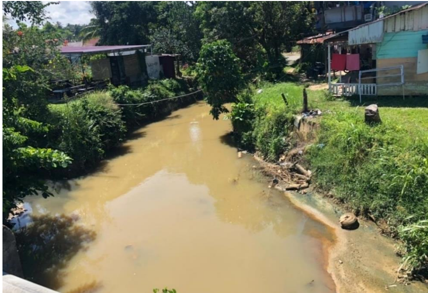
Gambar 4. 3 Penyempitan Dimensi Drainase Akibat Sedimen
