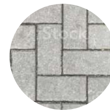
Pavement bata pada jalur kendaraan dan area parkir
