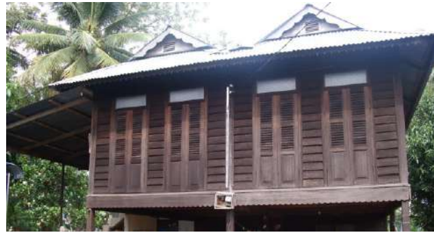
Jendela Rumah Melayu
