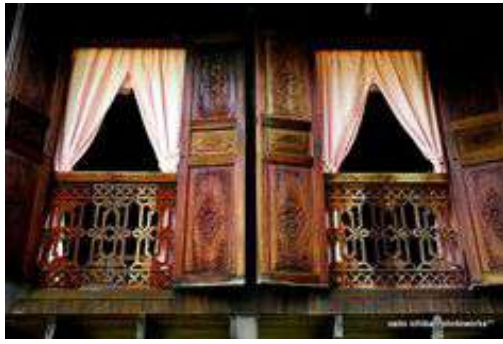
Jendela Rumah Melayu
