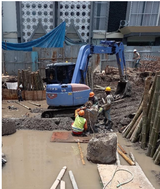
Gambar L-1.4 Pekerja Berdekatan Dengan Alat Excavator
