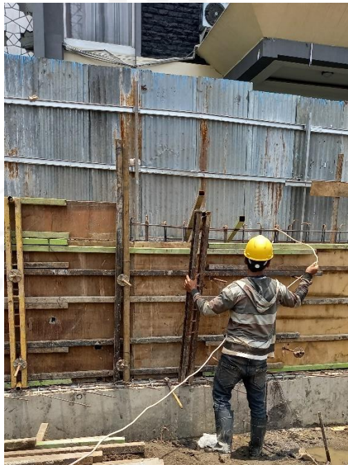
Gambar L-1.2 Kabel Yang Tidak Rapi
