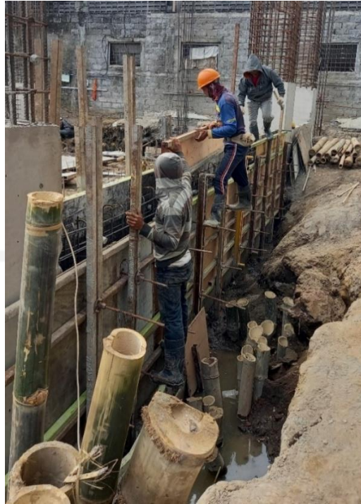
Gambar 5. 2 Pengamatan Pada Pekerjaan Pemasangan Beksiting
