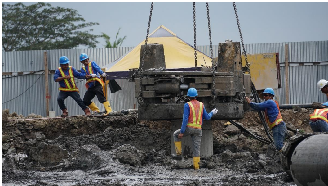
Gambar L-1. 9 Proses Penempatan Isolator
