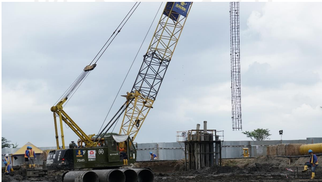
Gambar L-1. 10 Proses Instalasi Tulangan
