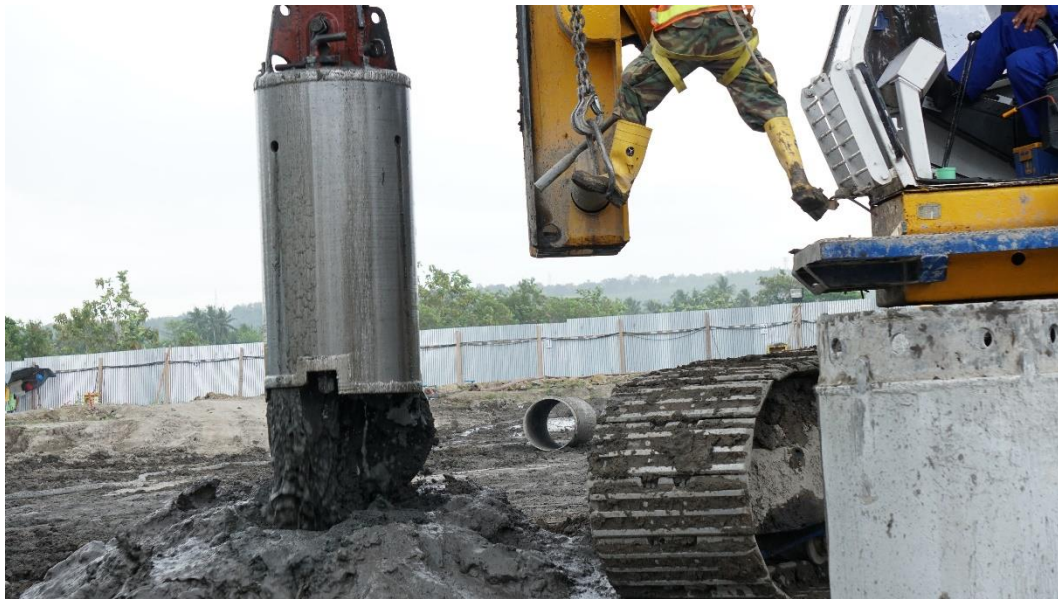
Gambar L-1. 5 Proses Pembuangan Material Tanah
