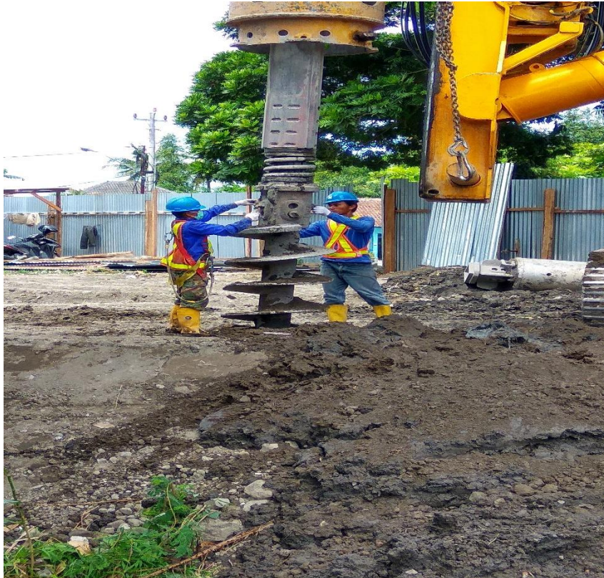
Gambar L-1. 3 Proses Pengeboran Menggunakan Mata Bor Auger
