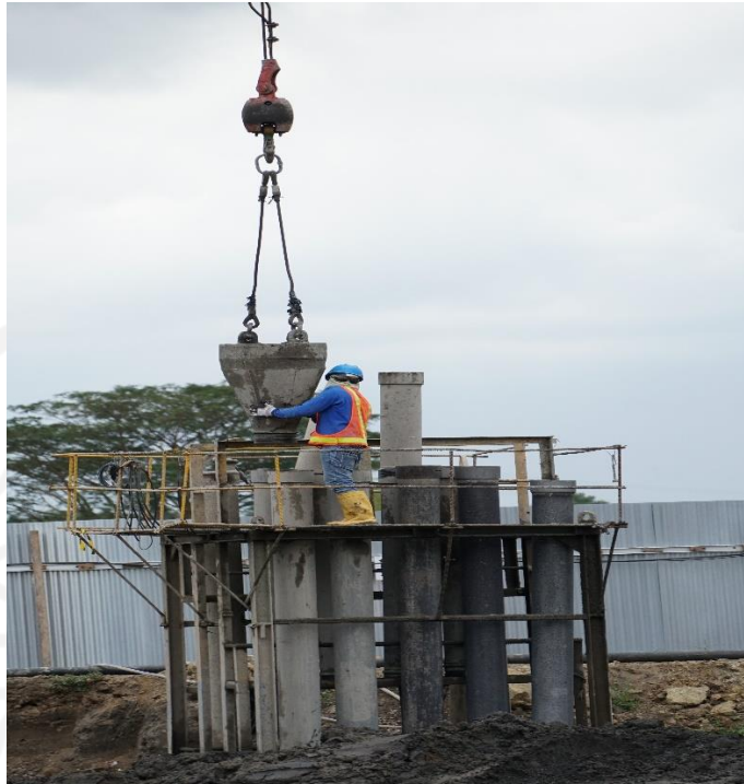
Gambar L-1. 11 Proses Instalasi Tremie
