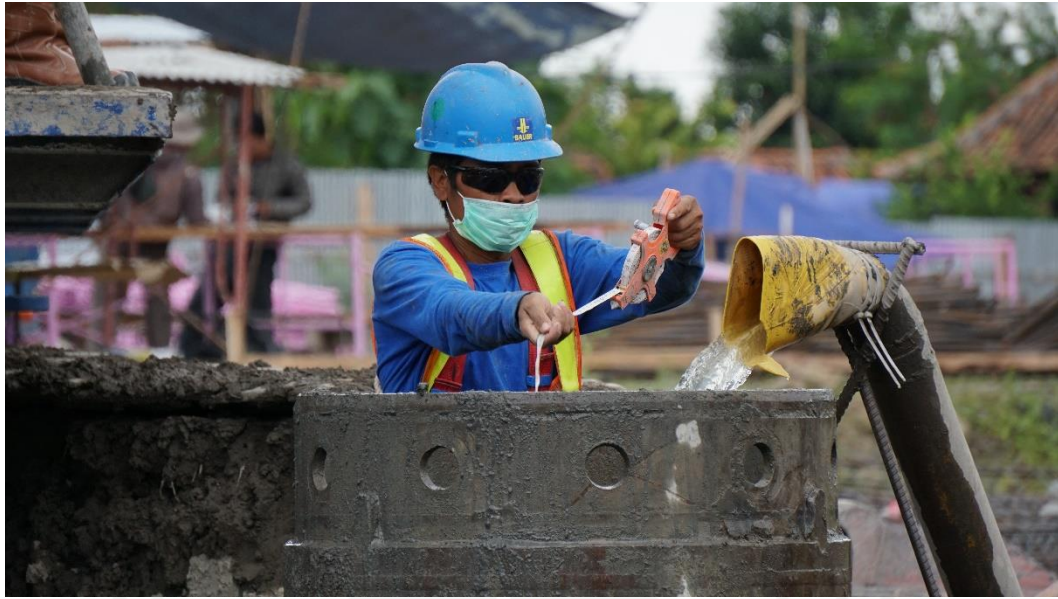
Gambar L-1. 7 Proses Pengukuran Kedalaman Bore Pile
