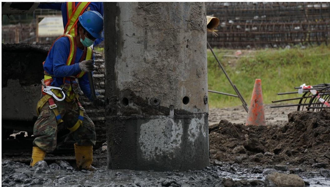
Gambar L-1. 6 Proses Penyambungan Casing Menggunakan Baut
