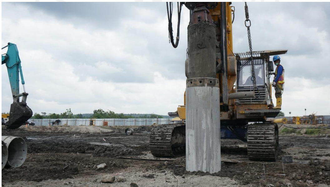
Gambar L-1. 4 Proses Pengeboran Menggunakan Soil Bore
