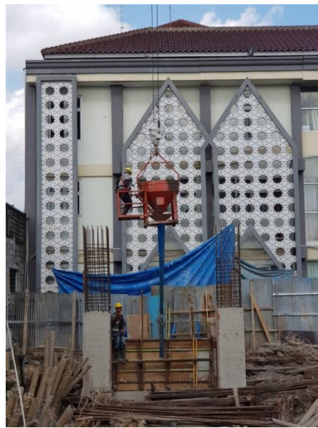
Gambar 5. 2 Proses Pengecoran
