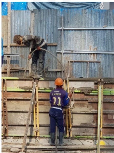
Gambar 5. 3 Proses Pemadatan Dengan Vibrator
