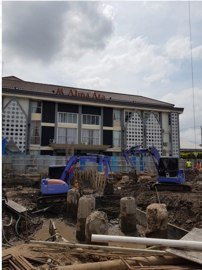
Gambar L-1. 6 Proses Estafet Penggalian dengan Excavator dan Area Kerja Sempit
