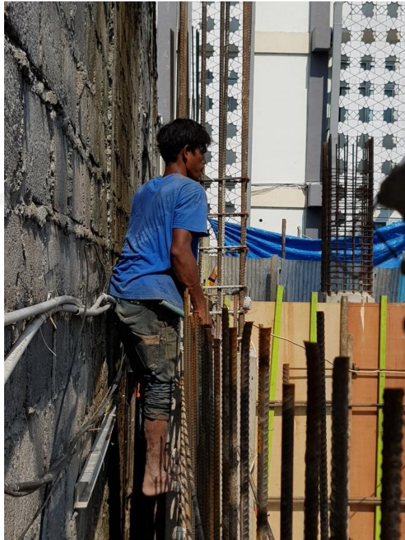
Gambar L-1. 3 Dinding Berdekatan Dengan Bangunan Eksisting
