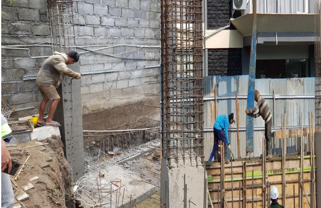
Gambar L-1. 1 Pekerja Tidak Memakai Alat Pelindung Diri (APD)
