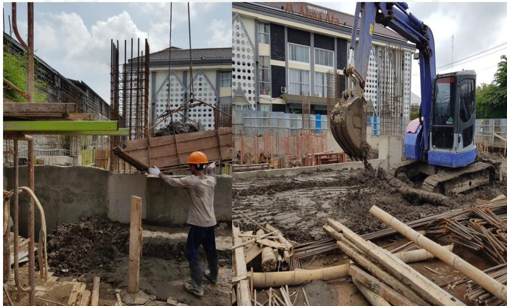
Gambar L-1. 4 Timbunan Dengan Bucket Tower Crane dan Excavator
