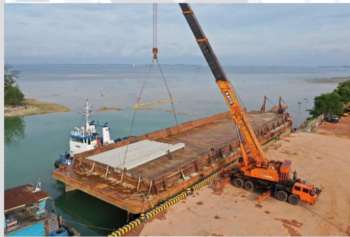
Gambar 5.10 Distribusi Full Slab dari Pelabuhan ke Ponton di Kota Batam (Sumber : Dokumentasi Proyek)
