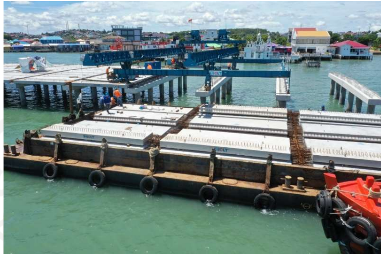
Gambar 3.3 Pelaksanaan Erection Slab on Pile dengan Launching Gantry (Sumber: PT. WIKACLT Proyek Pembangunan Gurindam 12)
