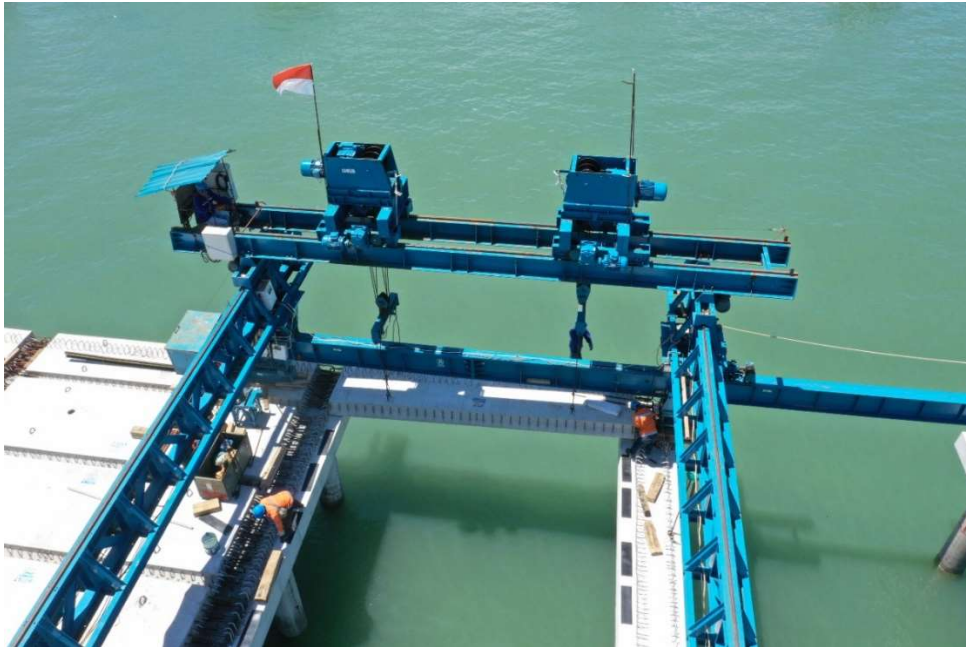
Gambar L-1.5 Peletakan Precast Full Slab pada Marking yang telah ditentukan di capping beam
