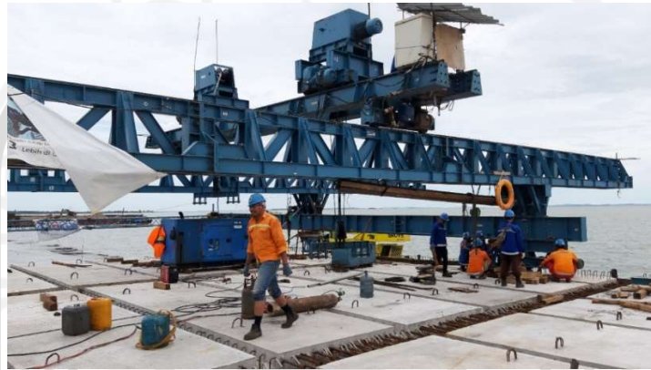
Gambar 3.6 Peletakan Precast Full Slab sesuai Marking (Sumber: PT. WIKACLT Proyek Pembangunan Gurindam 12)
