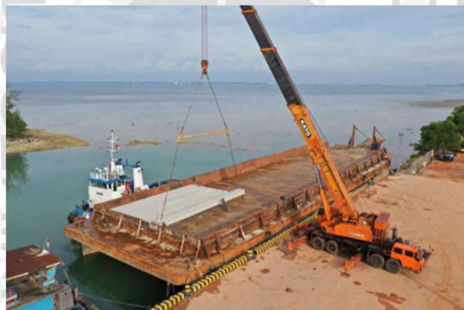
Gambar 3.2 Mobilisasi full slab precast menggunakan ponton dan tugboat ke lokasi proyek
