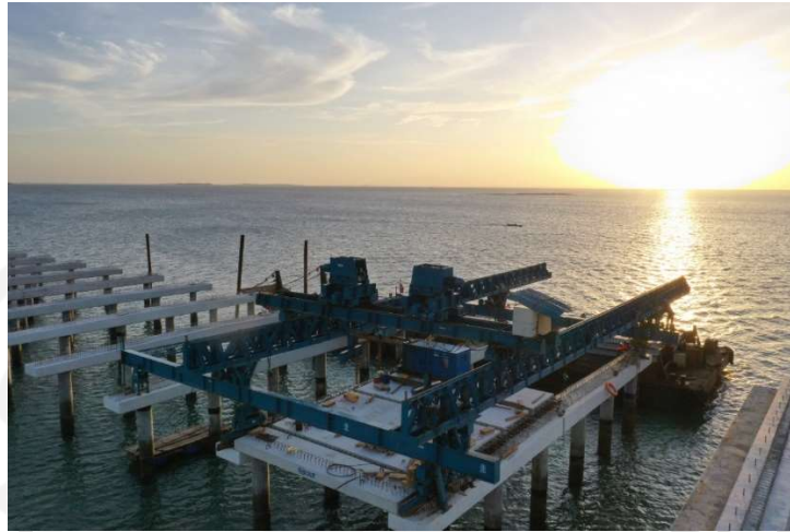
Gambar 5.4 Proses Erection slab on pile pada bentang pertama dengan launching gantry (Sumber : Dokumentasi Proyek)
