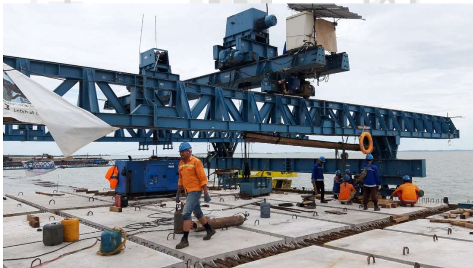
Gambar L-1.2 Pekerja dan Tukang pada Erection on Slab dengan Launching Gantry
