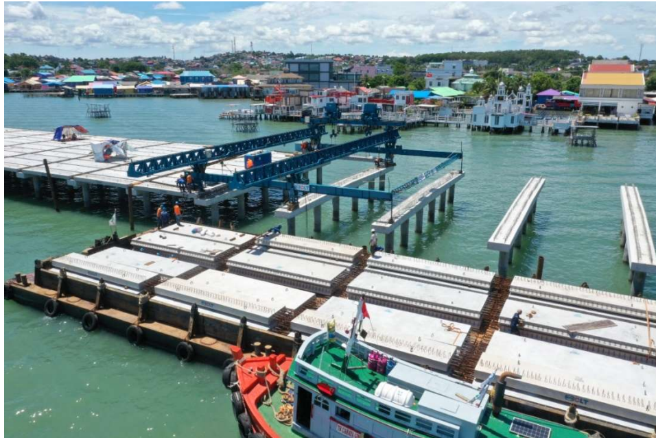
Gambar L-1.7 Pemasangan Precast Full Slab dilakukan per satu bentang atau Metode Span to Span
