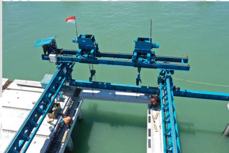
Gambar 3.4 Penempatan Erection Slab on Pile dengan Launching Gantry (Sumber: PT. WIKACLT Proyek Pembangunan Gurindam 12)
