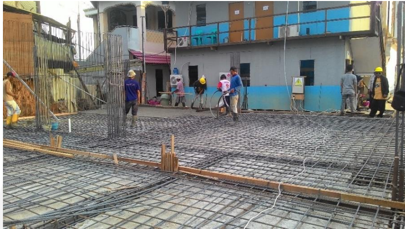
Gambar L-14.3 Perataan Cor pada Plat Lantai
