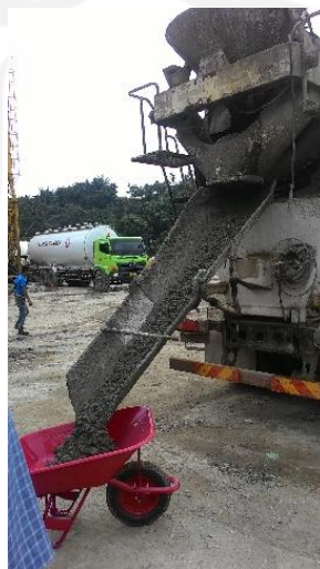
Gambar L-10.1 Penyaluran Cor dari Truk Molen
