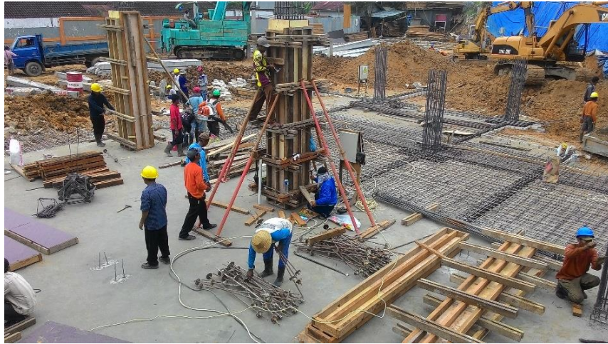
Gambar L-15.2 Proses Pemasangan Bekisting
