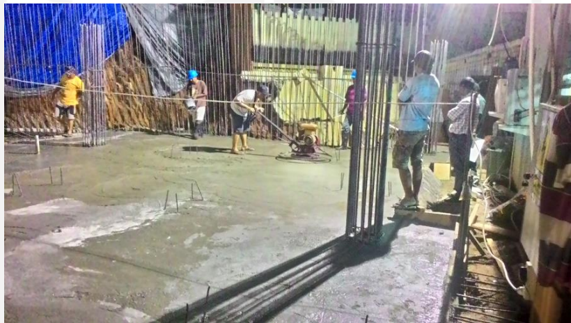
Gambar L-14.4 Pemasangan Setelah Dicur menggunakan Vibrator
