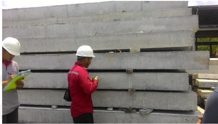
Gambar L-9.1 Proses Survey Tiang Pancang
