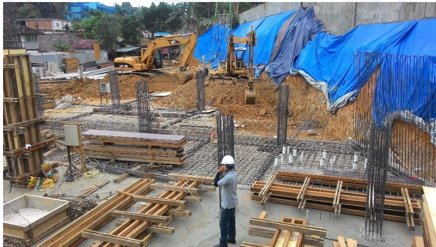
Gambar L-15.3 Beberapa Kolom Struktur dari Proses Pemasangan Bekisting di Proyek
