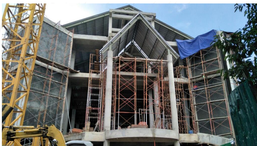
Gambar L-17.3 Proses Finishing Bagian Depan Proyek
