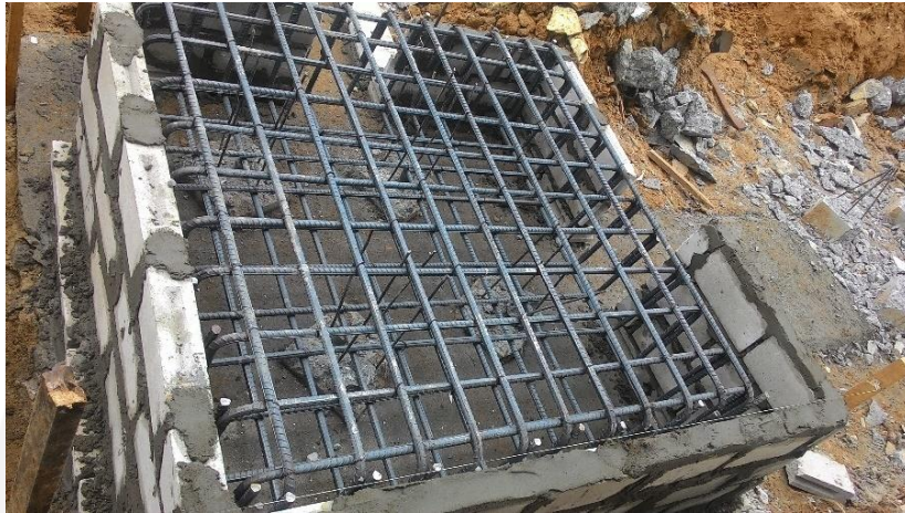
Gambar L-13.2 Proses Pengecoran pada Pile Cap
