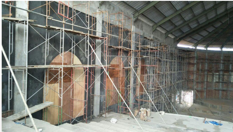
Gambar L-17.1 Proses Pengacian dan Pengecatan
