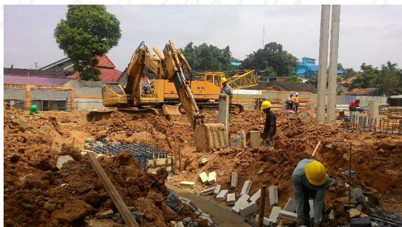
Gambar L-13.1 Pengerjaan Pile Cap
