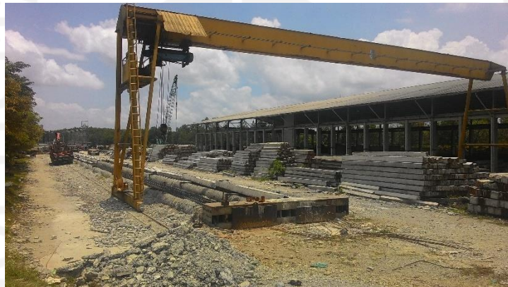
Gambar L-9.2 Lokasi Survey Stok Pancang di Pabrik Pembuatan
