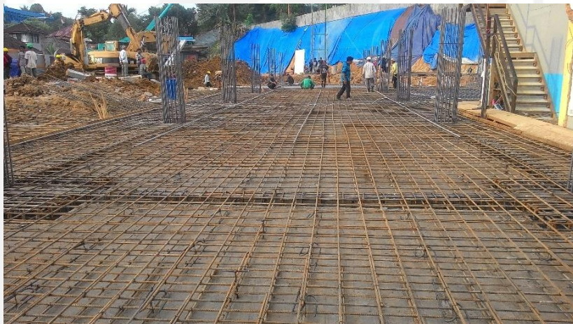
Gambar L-14.1 Pekerjaan Pembesian Plat Lantai
