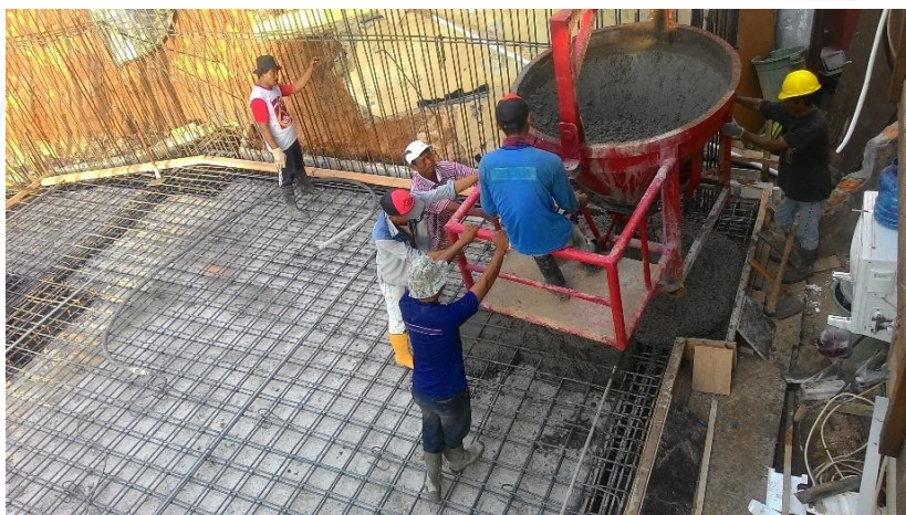
Gambar L-14.2 Pengecoran pada Plat Lantai
