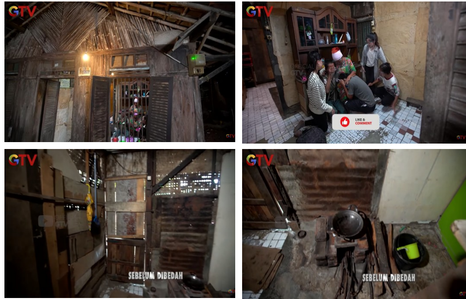
Gambar 5.4 Kondisi Rumah Pak Abas
