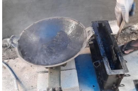
Gambar 13. Proses pencetakan interlock brick pada moulding
