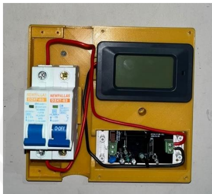
Gambar 4. 20 Pemasangan MCB Merk New Pallas
