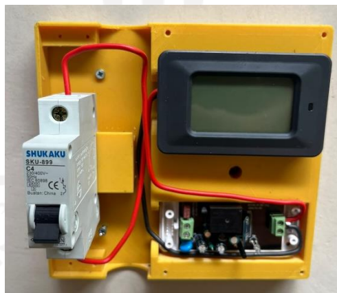
Gambar 4. 21 Pemasangan MCB Merk Shukaku
