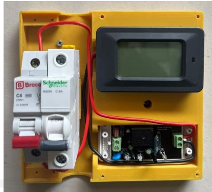
Gambar 4. 19 Pemasangan MCB Merk Broco dan Schneider
