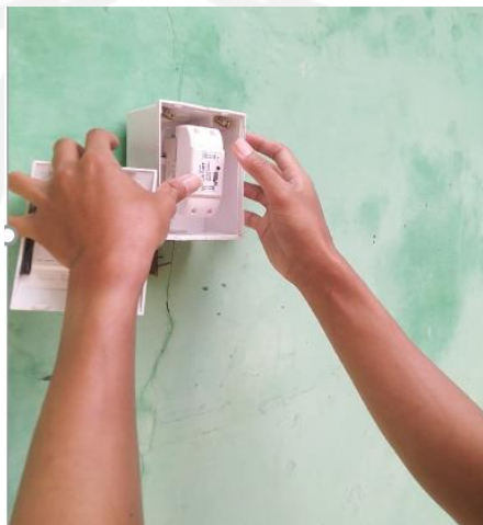
Gambar 4. 38 Percobaan pemasangan alat pada box MCB
