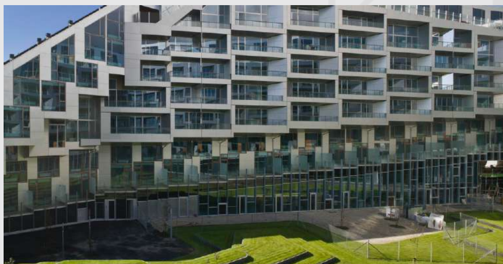
Gambar 1.13 Elemen shading sebagai pembentuk fasad - The 8 House (Sumber : https://archdaily.com )
