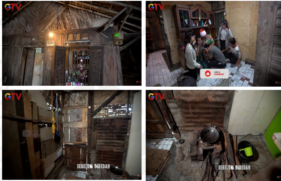
Gambar 5.4 Kondisi Rumah Pak Abas
