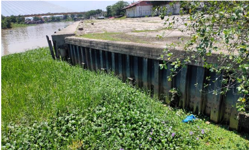
Gambar 47. Konstruksi Penahan Tanah (Turap) Pada Site (Sumber : Hasil Observasi, 2021)
