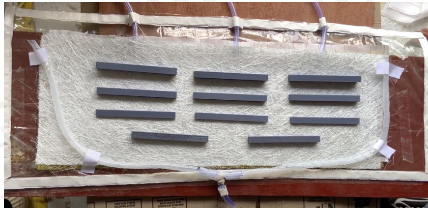
Gambar 3. 24 Pemasangan sealent tape
