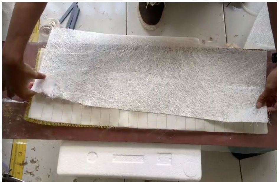
Gambar 3. 22 Pemasangan lapisan fiberglass
