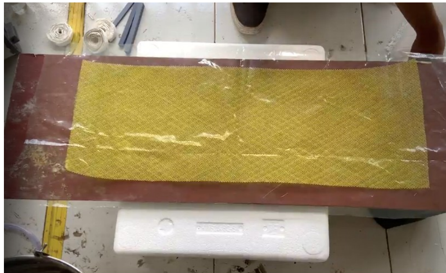
Gambar 3. 20 Pemasangan kain strimin
