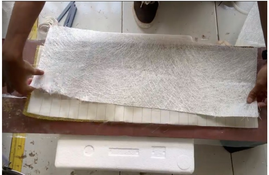
Gambar 3. 22 Pemasangan lapisan fiberglass
