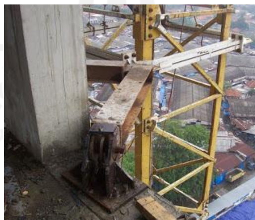
Gambar 3.3 Pengikatan Tied In Crane Pada Struktur Bangunan
