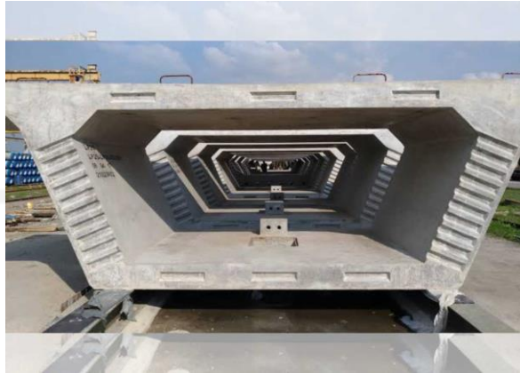
Gambar 3.6 Balok Tipe Box Girder
