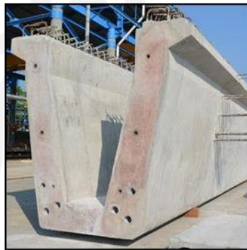
Gambar 3.8 Balok Tipe PC-U
