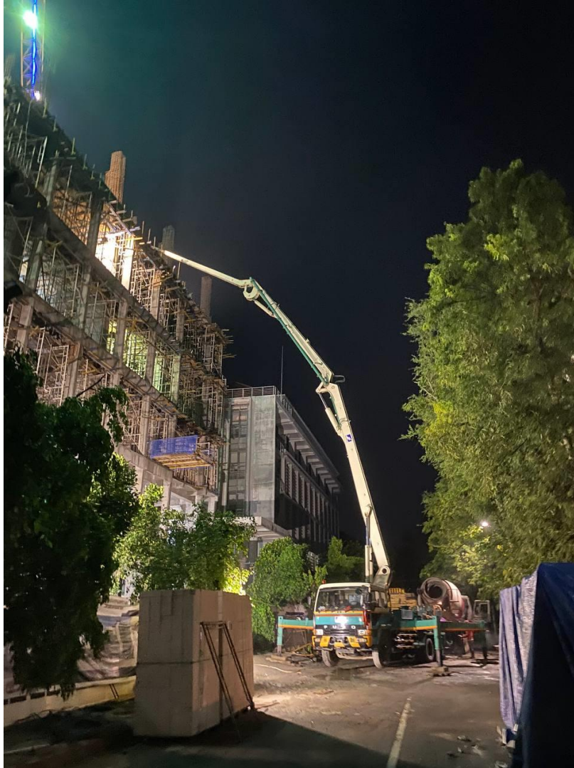
Lampiran 4.13 Gambar Pengecoran CP 7
