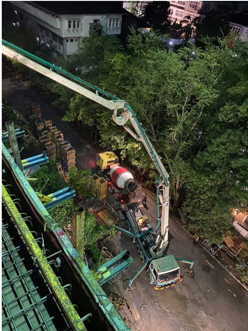
Lampiran 4.5 Gambar Pengecoran Menggunakan Concrete Pump
