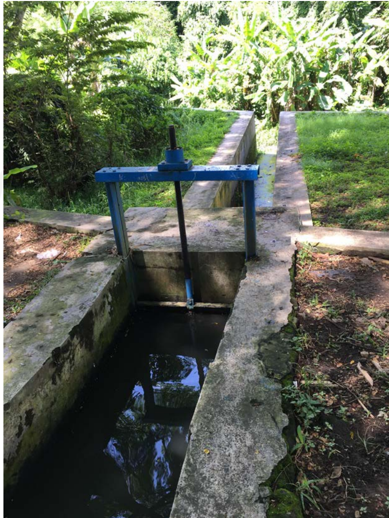
Gambar L-3.2 Saluran Pembuang dan Bangunan Pintu Penguras
