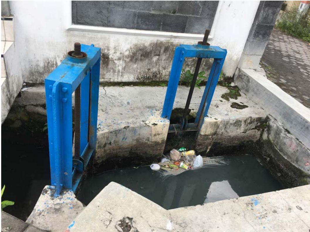
Gambar L-3.4 Pintu Tersier dan Sekunder Kanan
